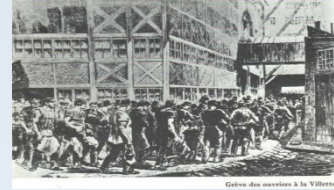
Gétre des ouvriers à la Villette
